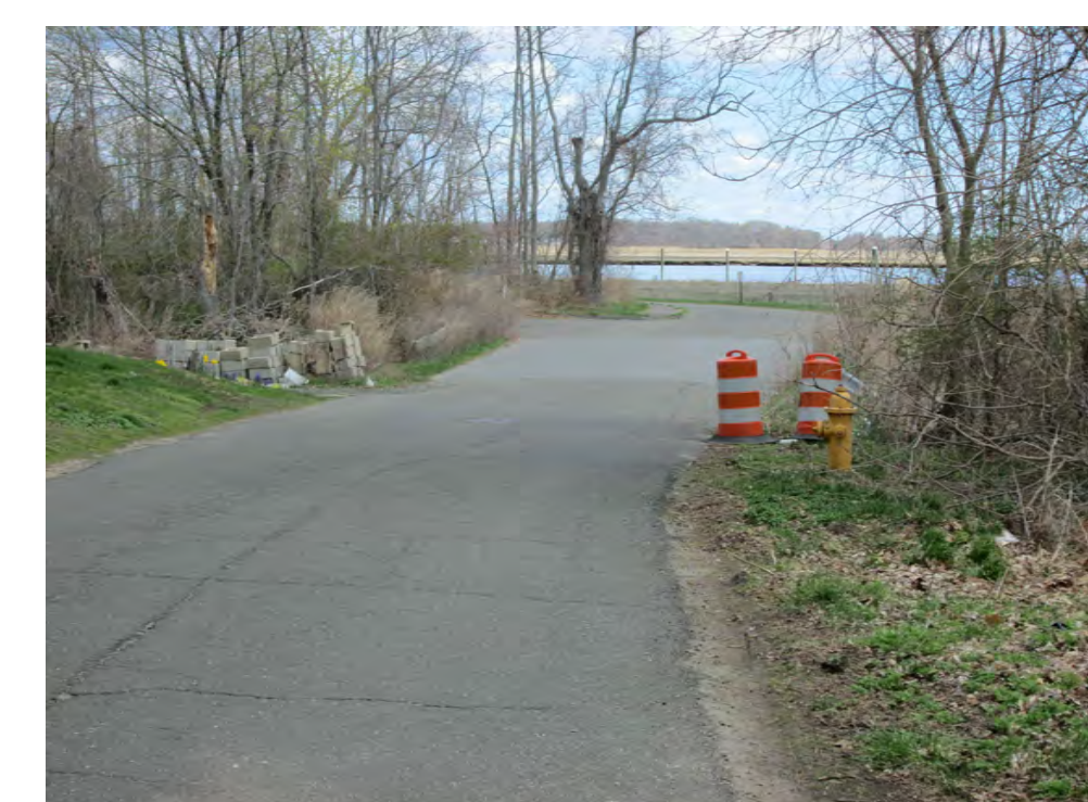
STA. 3+00 LOOKING EAST
