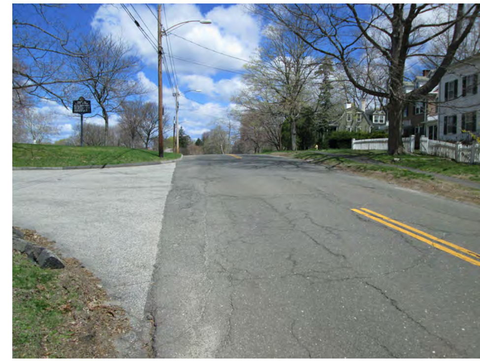
STA. 48+75 LOOKING NORTH
