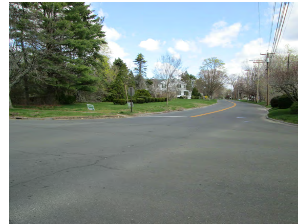
STA. 17+25 LOOKING NORTH
