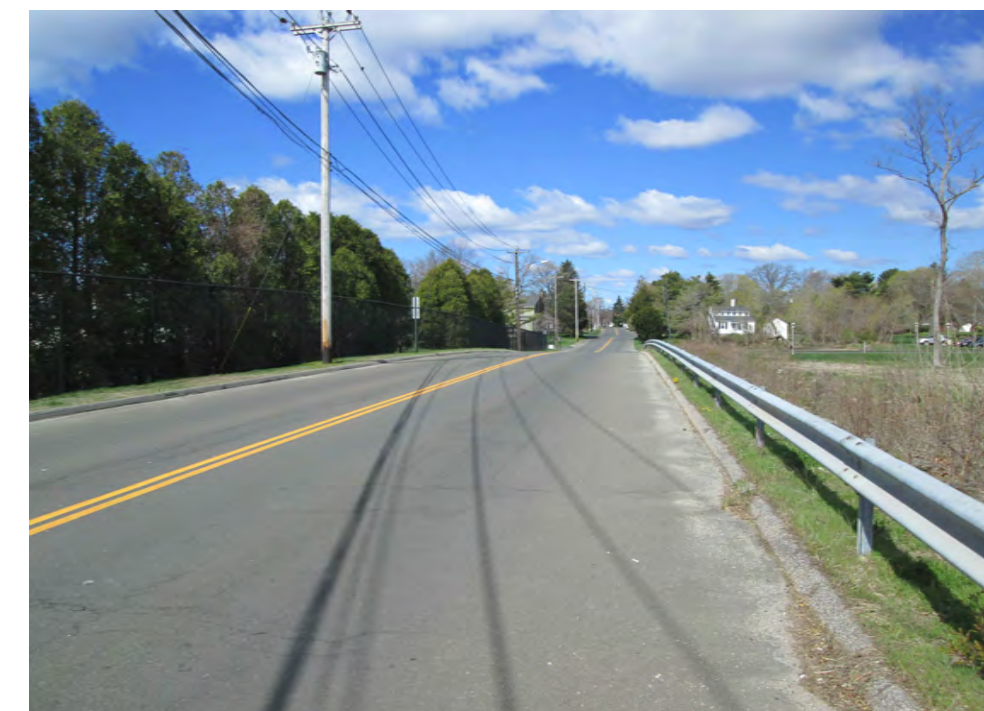
STA. 11+00 LOOKING WEST
