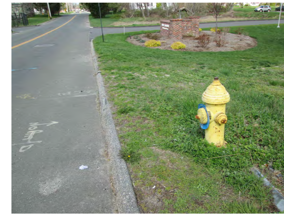
STA. 20+50 LOOKING NORTH
