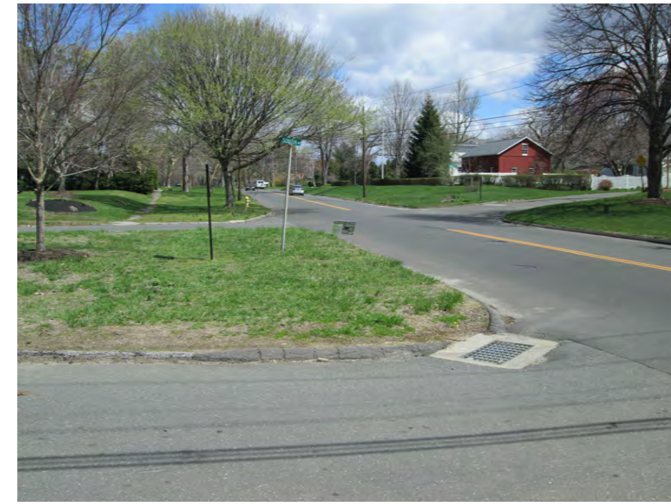
STA. 29+00 LOOKING NORTH
