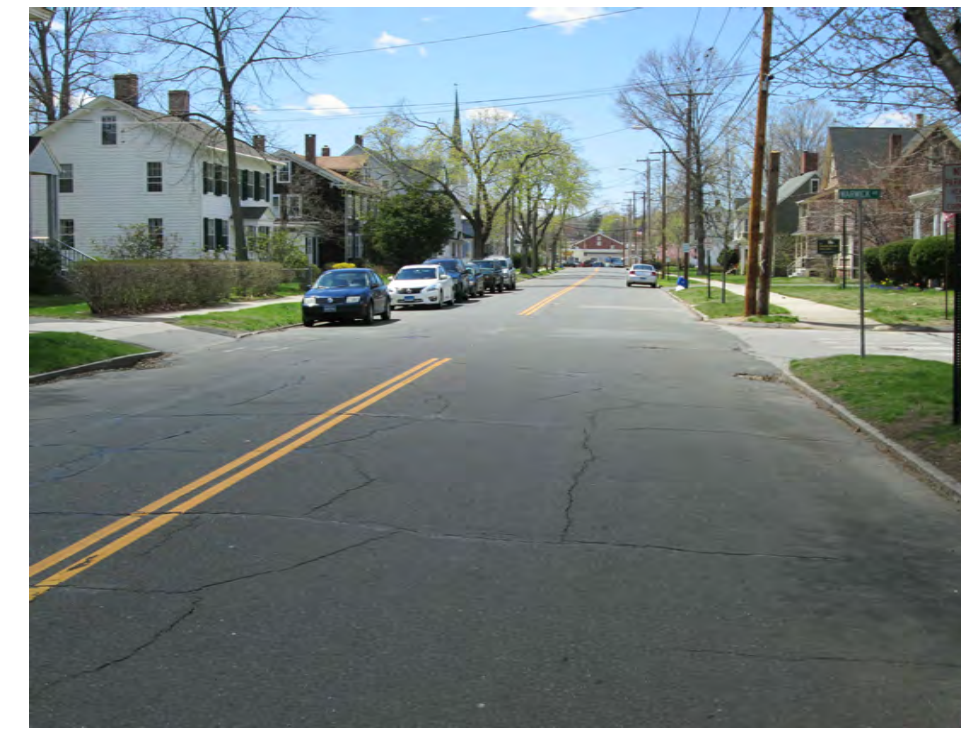
STA. 67+50 LOOKING WEST
