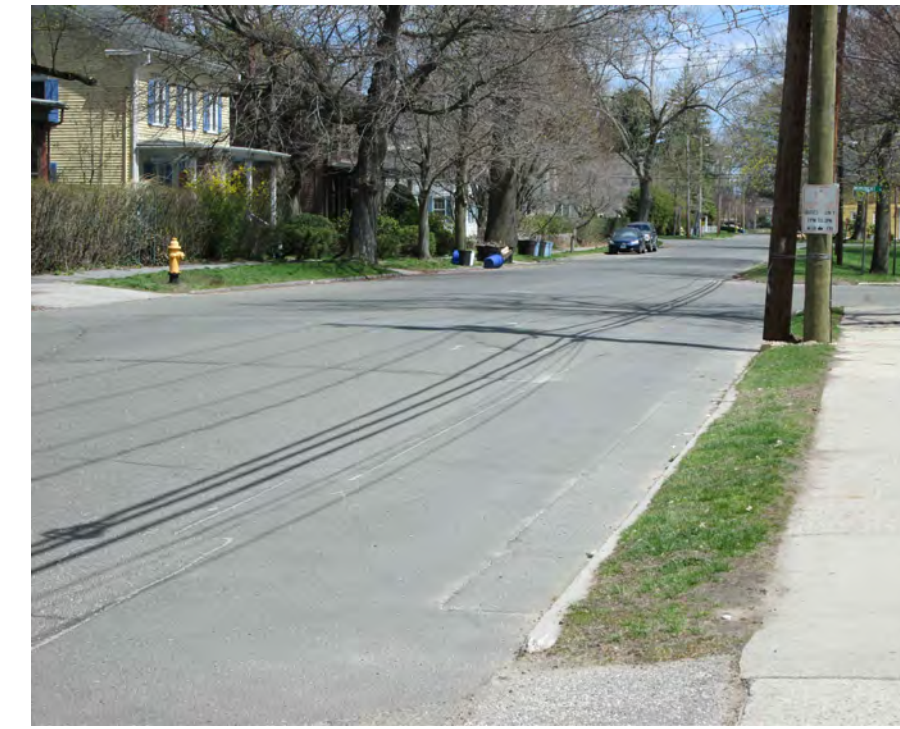
STA. 5+00 LOOKING EAST
