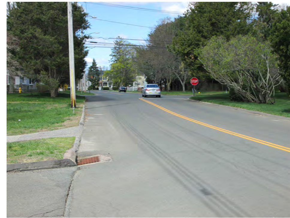
STA. 15+50 LOOKING EAST
